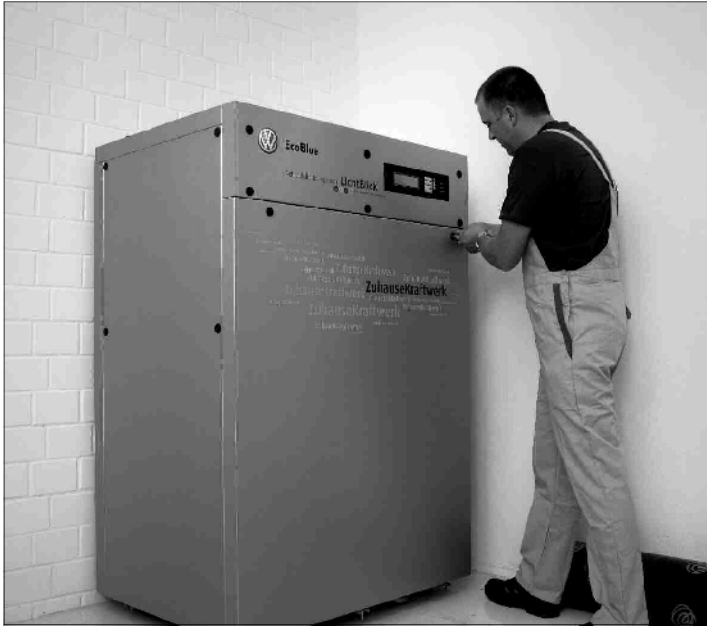
Ein VW-Motor ist das Kernstück der Mini-Blockheizkraftwerke
