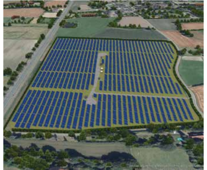
Ansicht West © 2025 ON Energy GmbH
